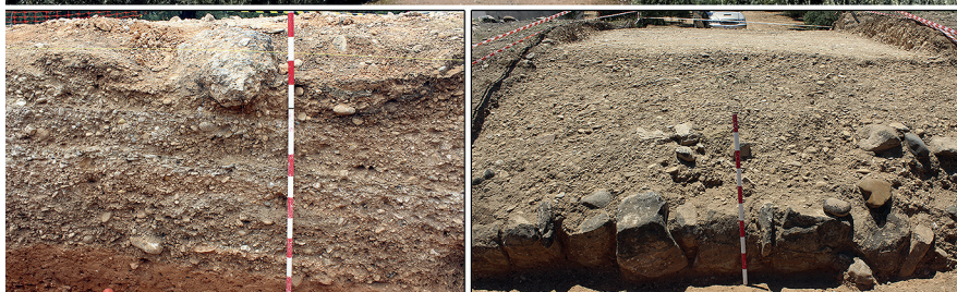
Camino de los Romanos (Mengíbar, Jaén) ( Via Augusta ). Arriba, trazado de la calzada hacia el oeste del Ianus Augustus , con dirección a Espeluy. Abajo, a la izquierda, sección arqueológica de la calzada, con la evidencia de las distintas reparaciones de la misma. A la derecha, detalle de los márgenes de la calzada.
